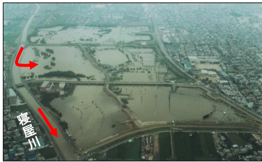
写真 2.4 寝屋川治水緑地の貯留状況
