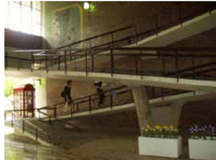
図 15 ピロティ内のスロープ
