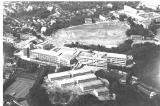
図 21 実験実習場・第4学舎1号館 (1960)
