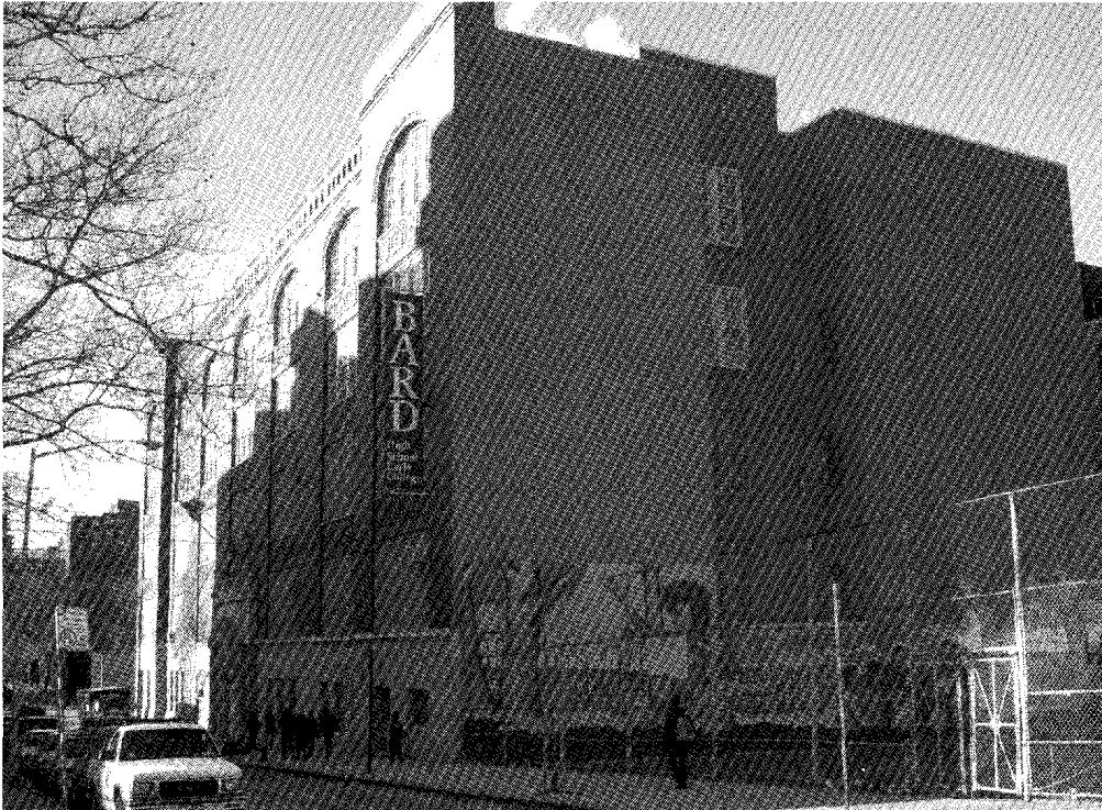
BHSECの建物外観（筆者撮影，2004年1月）
