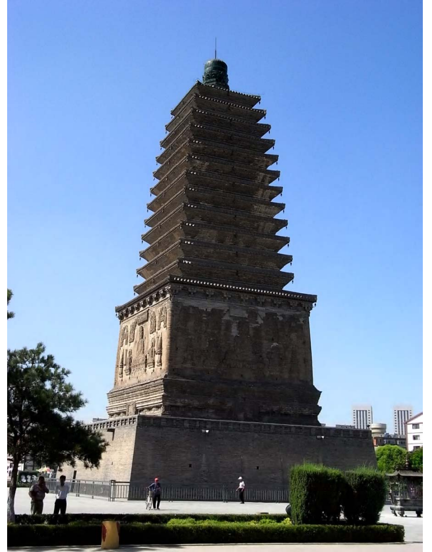
卷頭図版6 朝陽北塔（延昌寺塔）
