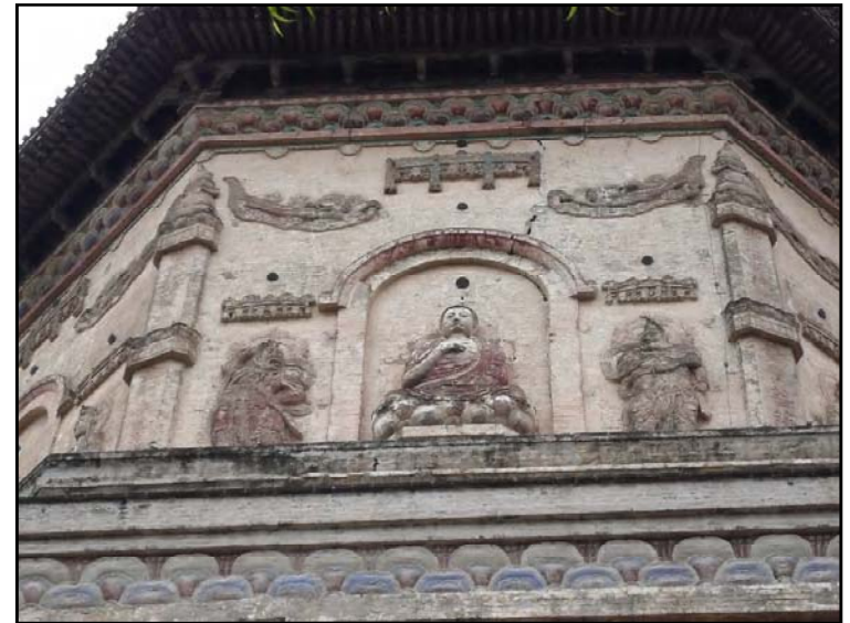
PL.4 中京大塔初層北西壁
