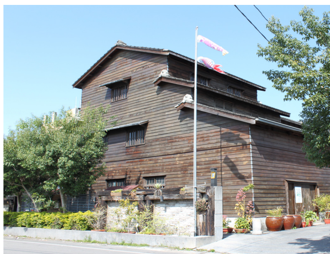
写真1 1942年に建てられた石岡穀倉（2011年2月5日筆者撮影）
