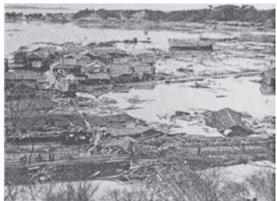
図3 昭和南海地震後の紀伊新庄駅付近 5)
