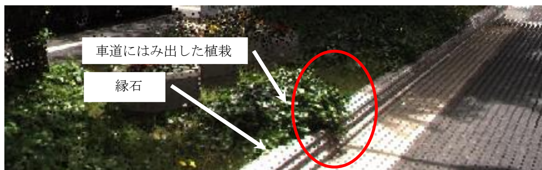
b) 路線1 地点A付近 写真と点群座標データの重畳
