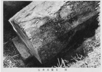
写真1 中尾山古墳の墳丘頂部と石槨天井石（1927年）
