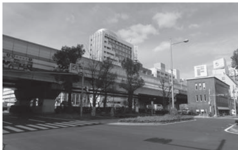
旧四ツ橋所在地 現況
