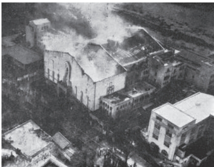
図11 壁を残して焼失した大劇場（1935/1）＊5
