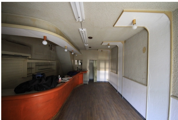
1階店舗部分を入り口から見る
