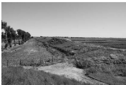
写真21 城四家子故城北城壁
