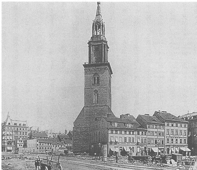
写真3 カイザーウイルヘルム通りの開通のため教会の周りの一角がけずりとられた工事現場（1888年）
