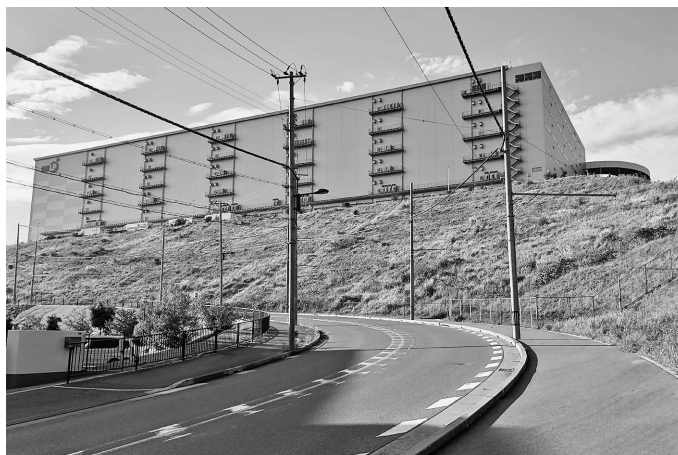
写真1 中央地区の物流施設
