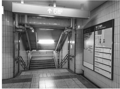
第14図 暗渠化された「排水路」 (名古屋市東区。暗渠化された「排水路」が地下鉄駅構内の通路の上部に張り出している。2020年2月7日著者撮影。)
