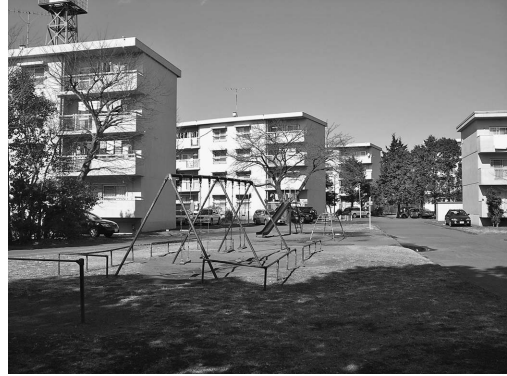
第8図 廃止された国土交通省（旧建設省）野毛宿舎 （東京都世田谷区。2007年2月11日著者撮影。）
