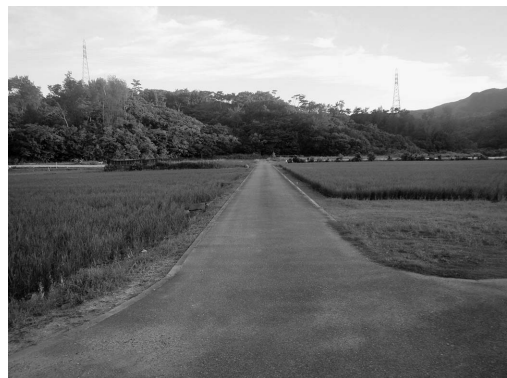
第2図 各水田に水を供給する「用水路」を併設した道路（「通作路」） （沖縄県恩納村。近年ではこのように「用水路」の多くがコンクリート張りや暗渠化され、その分、道路（農道）が拡幅されるようになっている。2022年9月9日著者撮影。）
