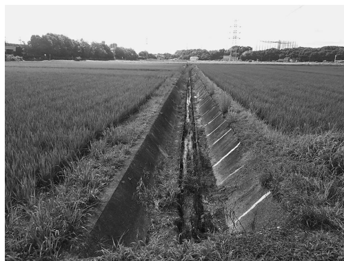
第3図 各水田からの水を排水する「排水(悪水)路」(愛知県春日井市。近年の「耕地整理」では、このように「排水路」も多くがコンクリート張りされている。2022年7月13日著者撮影。)
