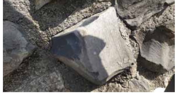
写真5・6 石垣の黒色ガラス質安山岩
