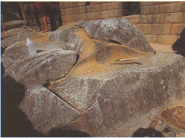
Fig. 11 自然岩基盤の割裂
