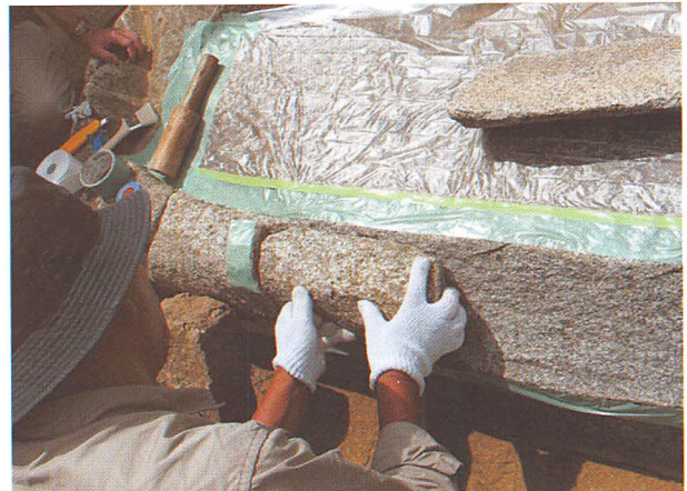
Fig. 21 基壇石の割断小片の再接合
