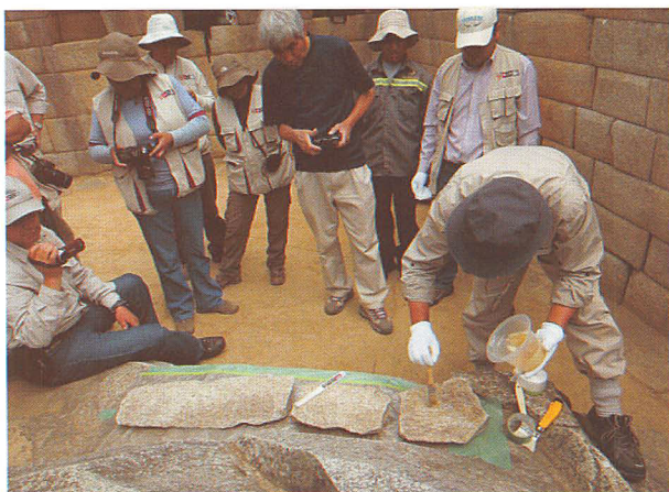
Fig. 21 基壇石の割断小片の再接合
