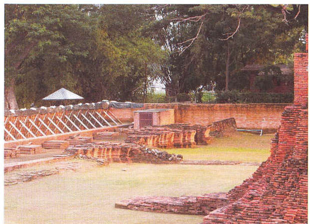
Fig. 13 人工的水遮断壁の設置（チャイワッタナラム寺院）
