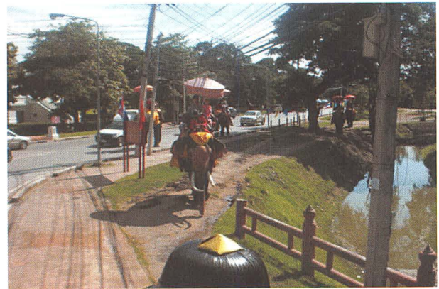
Fig. 11 道路によって寸断された運河
