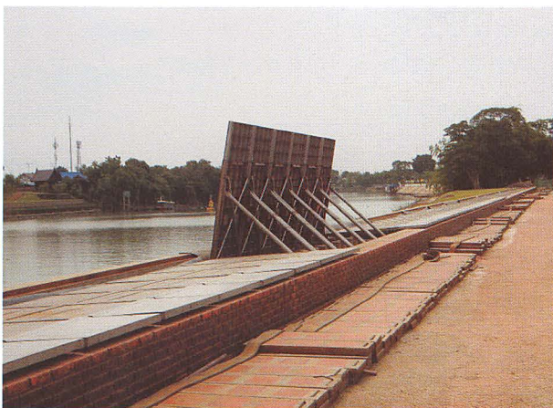
Fig. 13 人工的水遮断壁の設置（チャイワッタナラム寺院）
