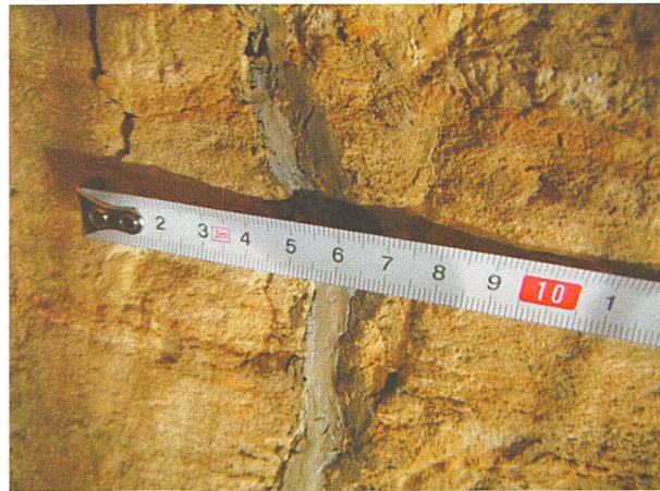
Fig. 10 充填された亀裂部の状況 (充填部)
