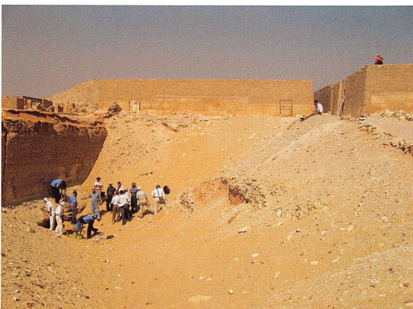
Photo 6 コアボーリング現場
