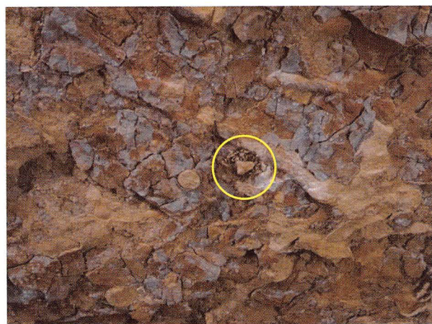
Photo 31 ボルト頭部補修
