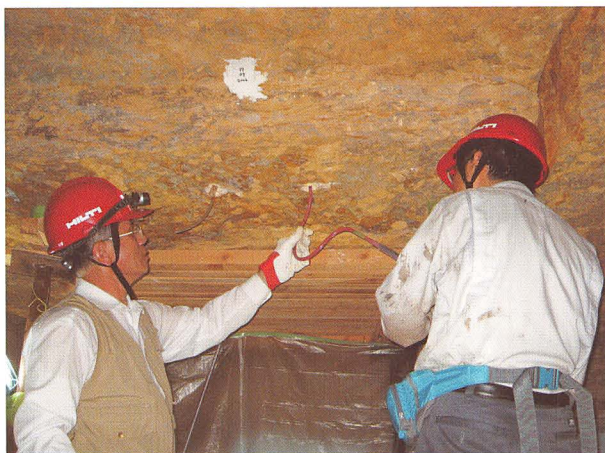
Photo 29 エポキシ樹脂注入
