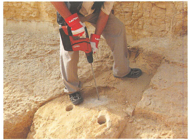
Photo 24 ハンマードリルによる削孔
