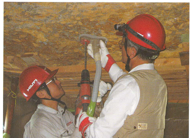
Photo 26 ハンマードリルによる削孔
