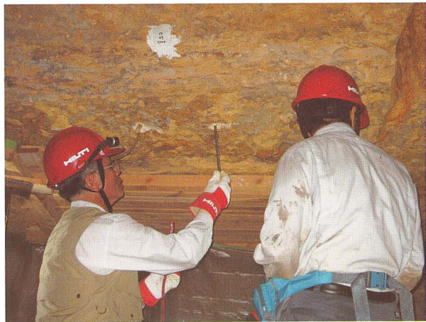
Photo 30 アンカーボルト挿入
