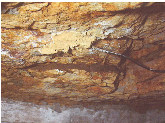
Photo 20 エポキシ樹脂 A による補修
