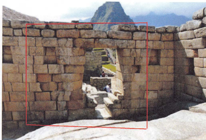
写真③ 仮称西開口部
