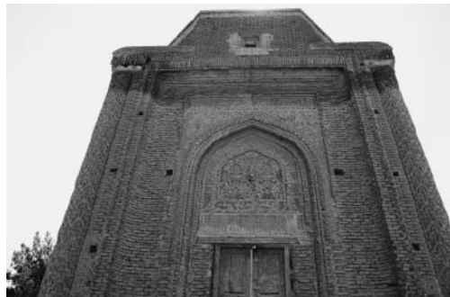
写真19 Gonbad-e Surkh の正門部分
