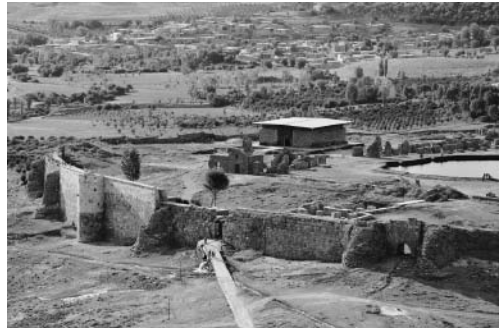
写真16 タフテ=ソレイマーン内のモンゴル支配期の建築群遺構。中央の屋根のかかっている建物が復元された博物館。城壁の左門がモンゴル時代のもの。右はササン朝時代の門。
