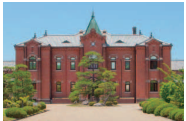
写真1 奈良少年刑務所庁舎（法務省 HP より）
