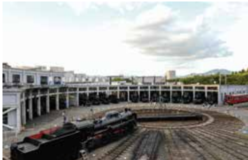
写真8 重要文化財の扇形車庫 (写真奥に広がるグレーの建物)
