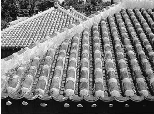
写真38 沖縄の瓦葺屋根
