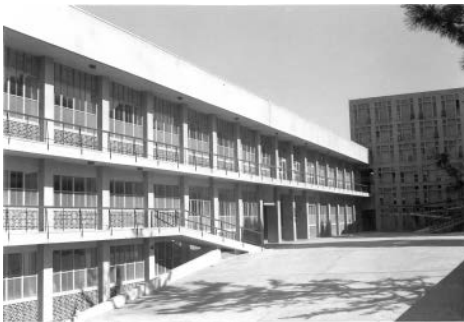
図5 西側から東へかけて3階建てから2階建てとなる第1学舎1号館の低層棟
