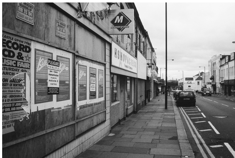
写真 11-1 1990 年代初頭のシールズロードセンターの荒廃状況 (1992 年 9 月筆者撮影)
