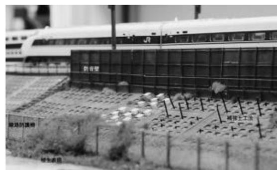
図2 張りコンクリートブロックと地山補強土工法の拡大図
