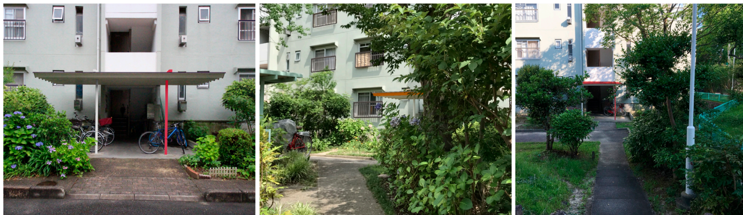
エントランスの周りの塗装計画は、各階段室のアクセントカラーを設定し、「自分の」住まいのある階段室として意識してもらえるようなアイデンティティを生み出すことを意図しました。また、塗り分けは3パターンありエントランスへのアプローチや緑道からの見え方によって使い分けています。
