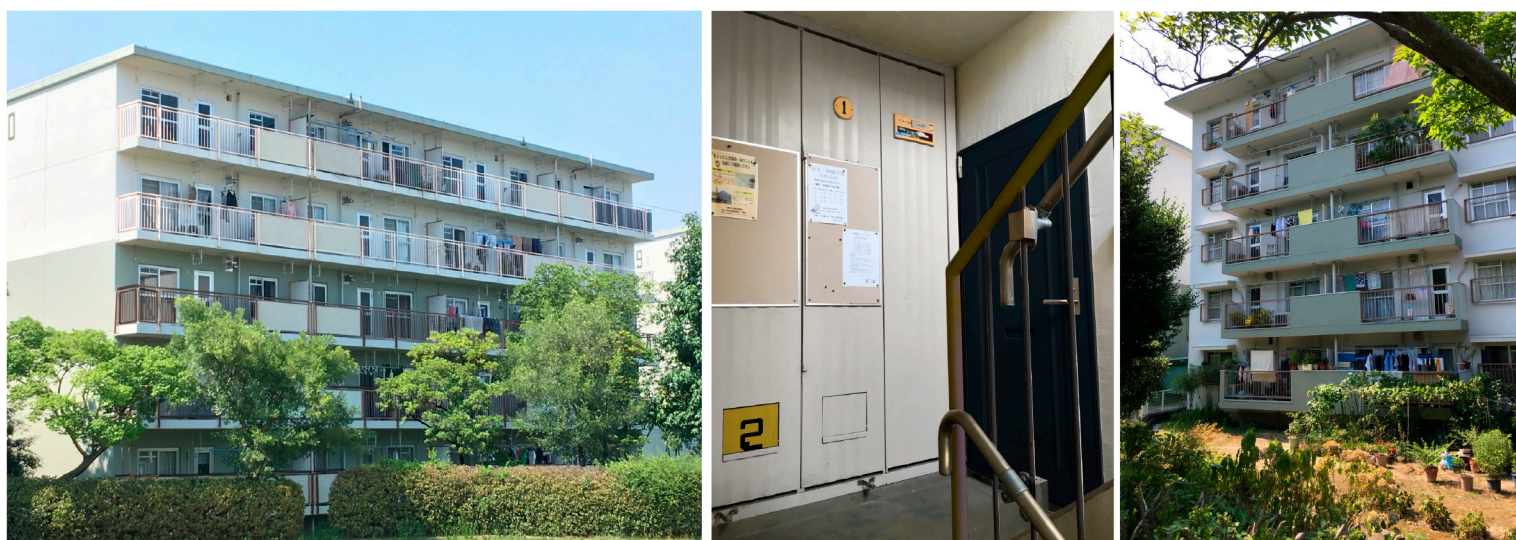
南側のバルコニー手すりは、C地区の豊かな緑が映えるように下3階は消し炭色、上2階は銀ねずみに塗装します。階段室は、玄関扉は鉄紺色でパイプスペースを白色に塗装し、モダンな仕上げとしました。中央を分断していた手すりを消し炭色で塗装し消すことで、階段室を広く見せます。
