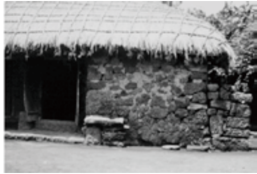
写真16 玄武岩で積んだ壁の立面
