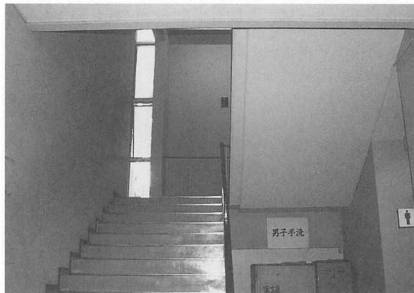
図12. 東側階段（旧館1階上り口部分）
