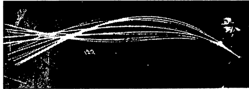
図1 筧の撓いのキネマティックス。 図では長い棒を振って筧状に撓らせたときの変形の時間的な継起が示されている。1880年代にエティエンヌ＝ジュール マレが運動する対象を1枚の乾板の上に多重露出して連続的に記録する方法を考案して、クロノ・フォトグラフと呼んだ。写真は実験中のマレ（1886）。E.マレ（横山正・訳）『運動』リプロポート, 1982, p. 199より。
