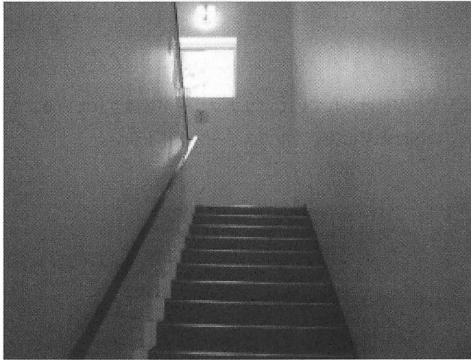
写真9. 4号館の階段（1階から2階へ上がる場所）
