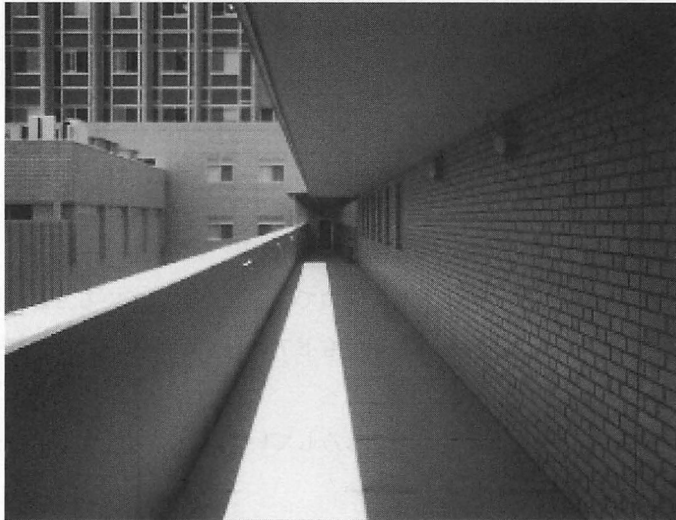
写真6. 3号館と4号館とをつなぐ5階部分の通り道 注) 写真の手前の建物が4号館で、奥の建物が3号館である。
