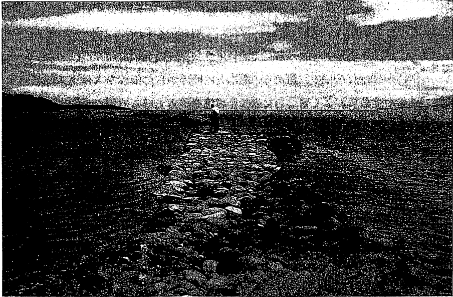
写真2 石積み堤と水門（ウアラプエU'alapu'e池，モロカイ島） 人物が立っている所が水門（マカハmakaha）である（1995年9月）。
