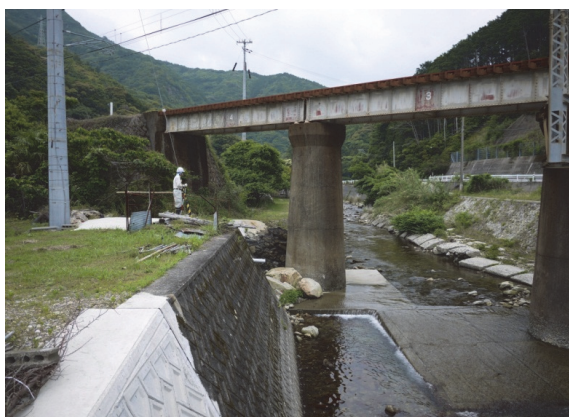
(a) 橋脚全景
