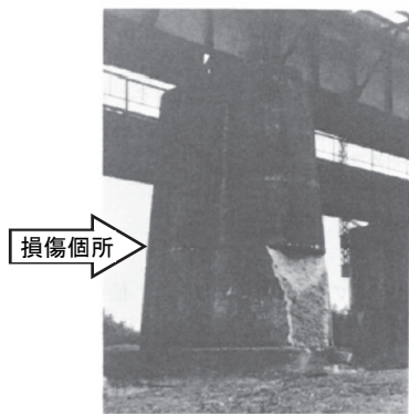
図4.1 損傷状況(2P橋脚) 2) に加筆
