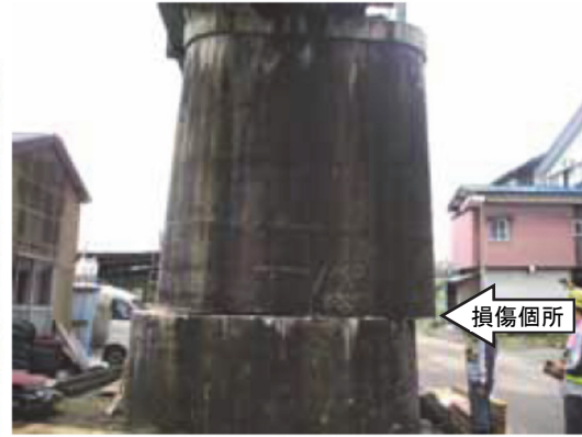
図 4.10 打継目での水平ずれ(15P) 9) に加筆
