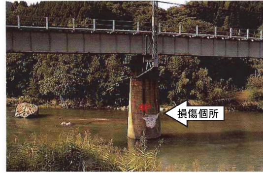
図 4.4-1 第 6 日野川橋梁の損傷状況 8) に加筆
