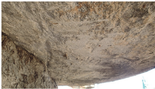
(a) 2P 橋脚
