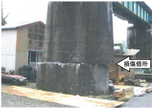
図 4.9 打継目での水平ずれ(15P) 9) に加筆
