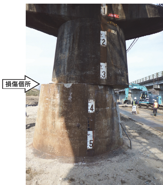
(a) 打継目のずれ
