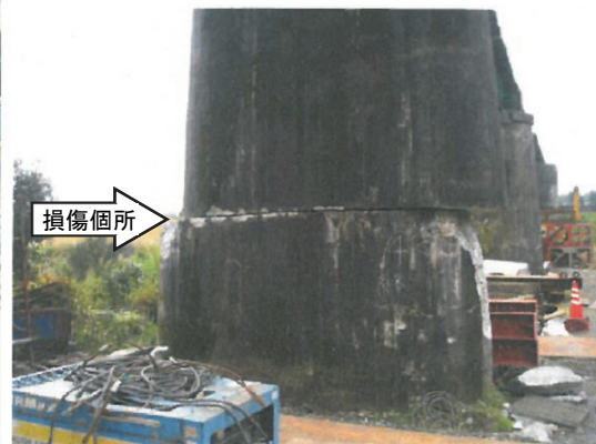
図 4.8 打継目での水平ずれ(14P) 9) に加筆
