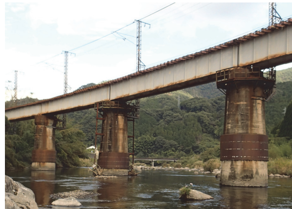
図 4.5 復旧状況 (第 6 日野川橋梁)
