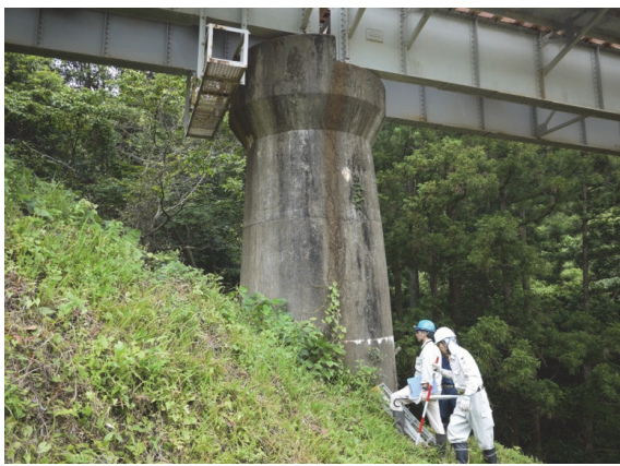
(a) 橋脚全景
