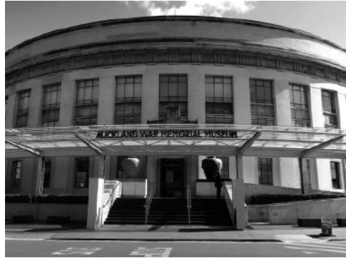
写真4 1960年に建物後方に増築された半円形のアトリウムの外観
