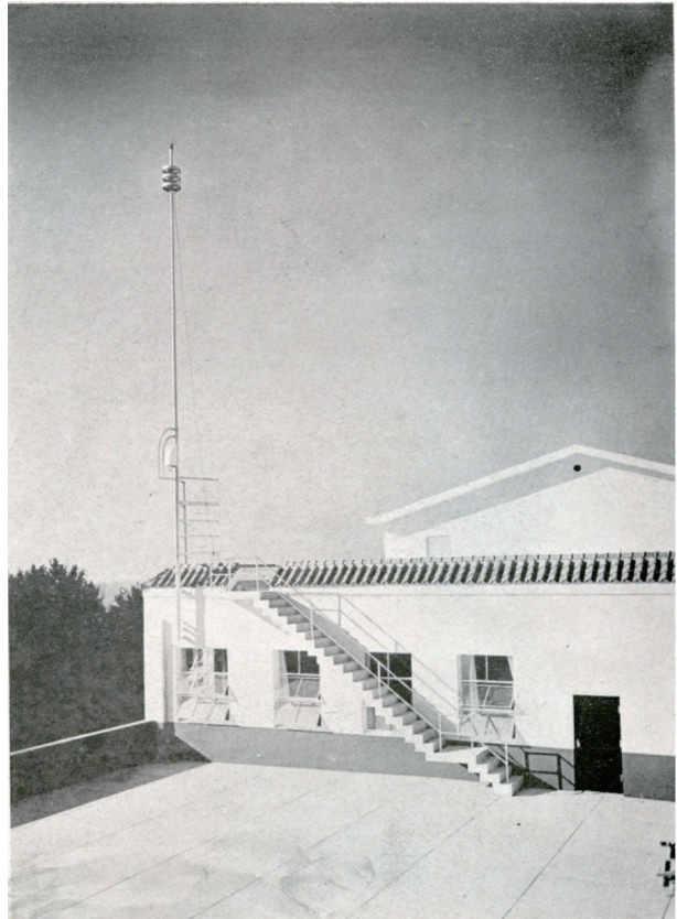
図11 3階バルコニー* 屋上への階段はモダニズムの建築らしさがよく表われている。
