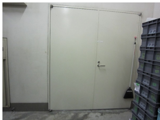
写真2 特別収蔵庫出入口
