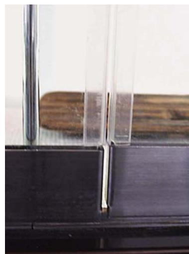
写真 25 開口部の隙間
