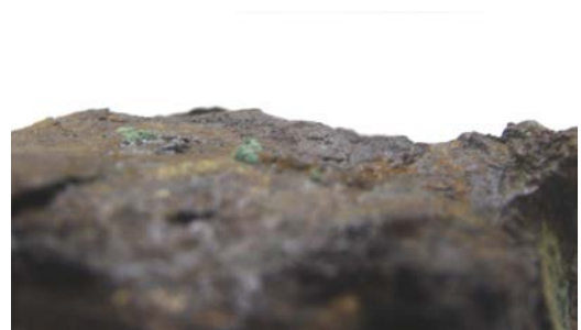
写真4 錆の発生状況
