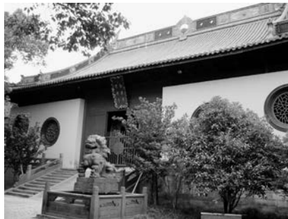
現在の杭州浄慈寺山門
