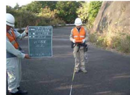
写真5.3 VLF-EM法探査状況
