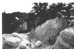
写真3:No10の造成工事
