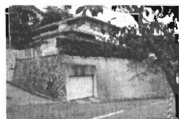
写真2:コンクリート擁壁が立ち現れている敷地
