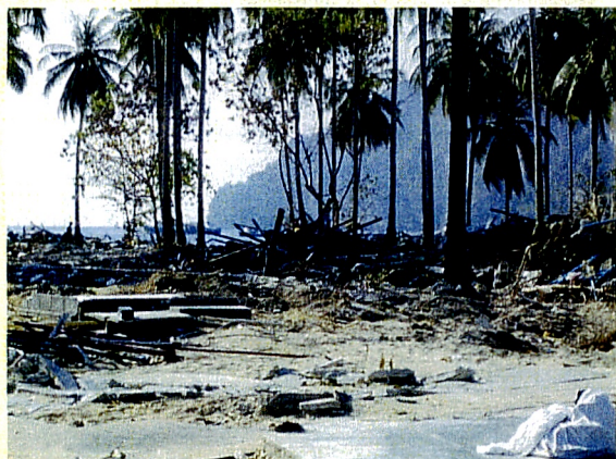
写真-1 タイPhi Phi島南岸の港付近の津波被害（写真撮影：高橋智幸（秋田大学））
