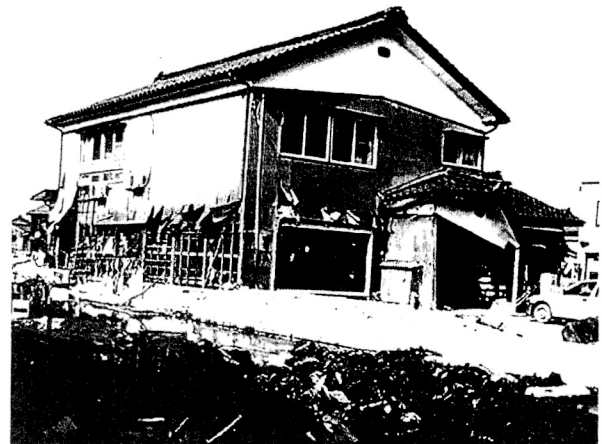
写真-1 被害判定に用いた外観写真の一例
