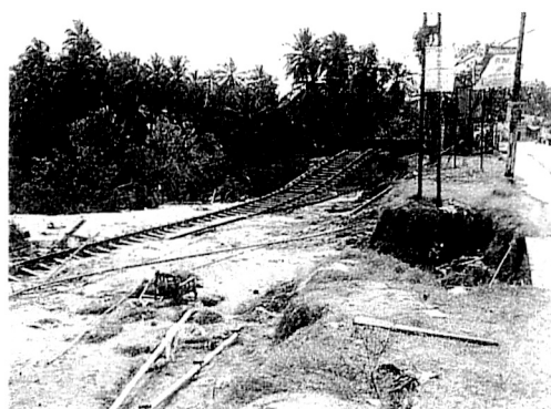
写真-2 Ambalangoda における津波による鉄道基礎の洗掘
