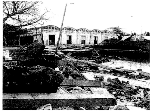
写真-1 ゴール港における岸壁の破壊
