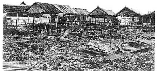
写真-2 被害を受けた高床式住居
