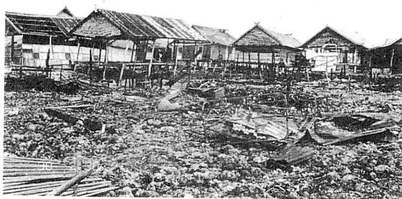
写真 7. 2 被害を受けた高床式住居
