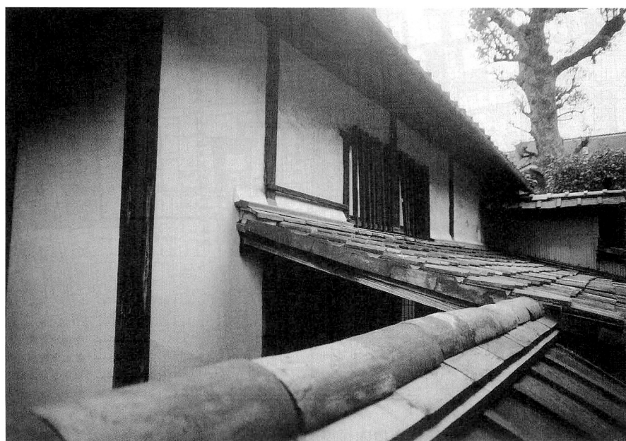
写真8 久昌院書院西妻に掛る露地の屋根
