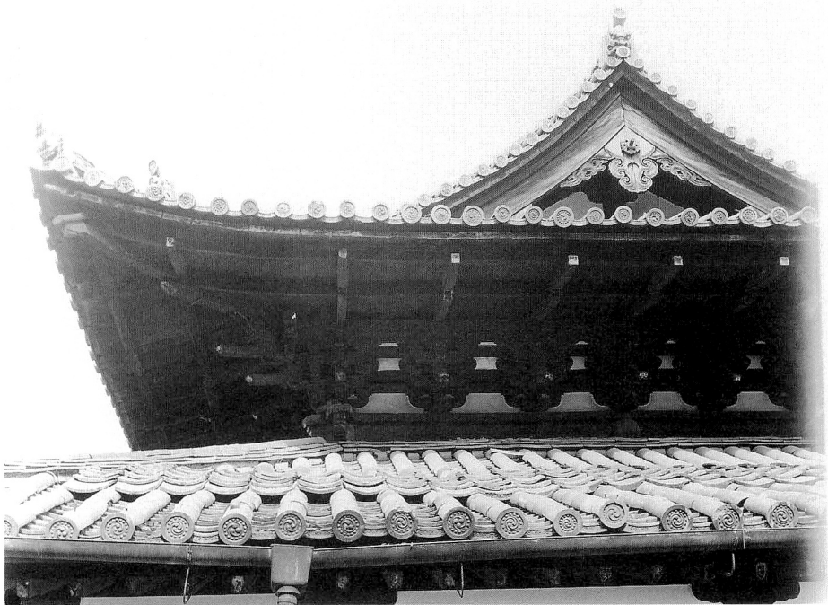
写真2 摩利支天堂側面 詰組、二重大疎垂木の軒廻りは創建時のまま
