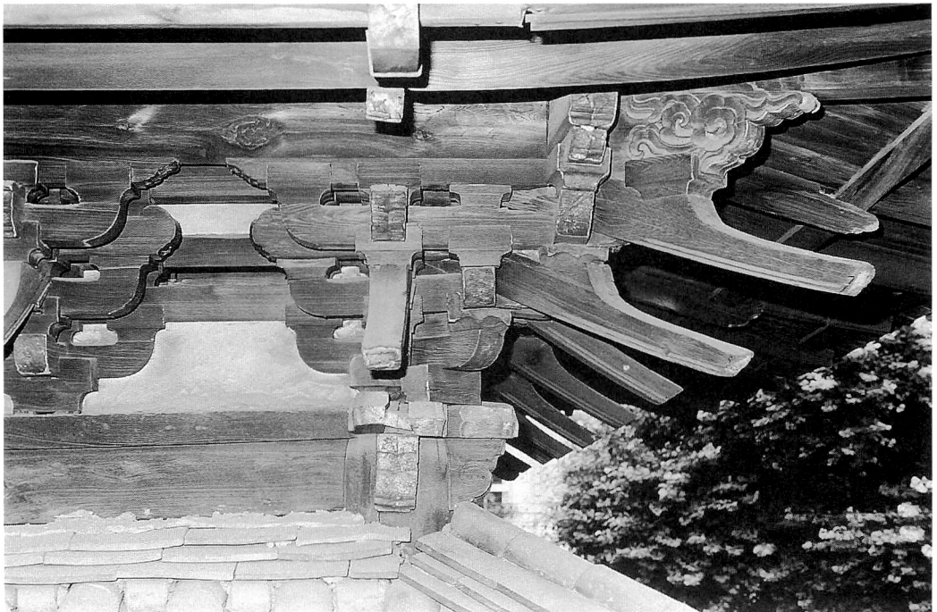
写真4 摩利支天堂上層軒下詳細
