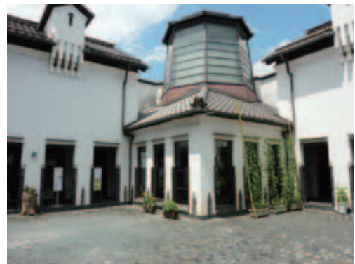
中庭から見たエントランスホール
