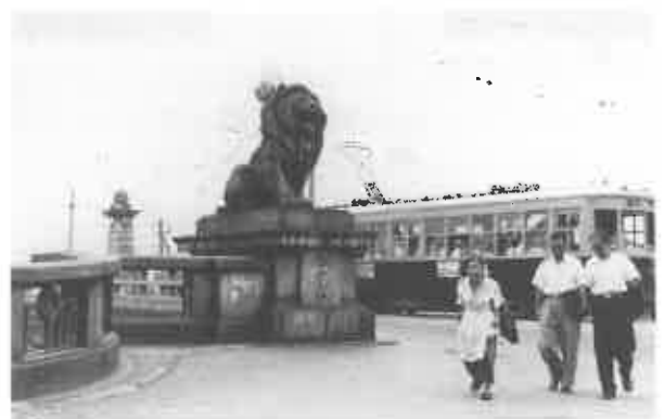
図1 難波橋（昭和29年7月撮影）
