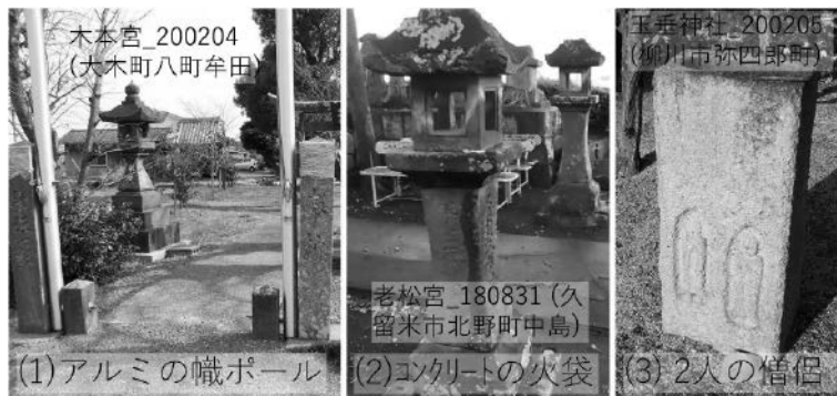
写真3 材の風化と対応例
